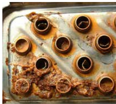
Sedimentos emulsionados en el intercambiador de calor con suplementos de turbulencia
